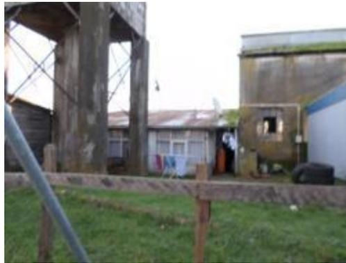
Bodega antigua: construcción de albañilería de ladrillos en doble altura, radier de concreto afinado, cubierta de planchas acanaladas metálicas. En mal estado de conservación
