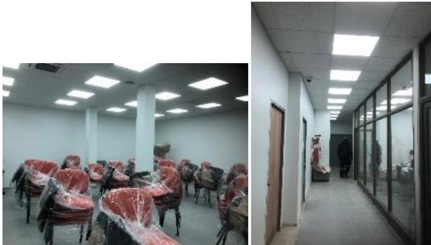
Piso 1: muros interiores estucados y pintados, con ventanas fijas en perfil de aluminio y en baño con azulejos, en acceso ventanal de piso a cielo y puertas de abatir de dos hojas en oficinas puertas de madera, pavimentos cubiertos con cerámicos en hall de atención, alfombra en oficinas y flexit en baños, cielo falso bajo losa de entre piso, con palmetas e iluminación fluorescente.
