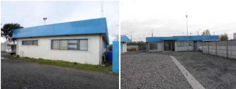
Sala de Capacitación: construcción en estructura metálica, revestidos en exterior con planchas tipo zinc alum, y forradas interiormente con panelería pintada, vigas de soporte al interior, cielo falso bajo techumbre metálica y lámparas fluorescentes incorporadas, puerta de acceso en madera de dos hojas, con porche de acceso, pavimentos cubiertos con flexit, ventanas en perfil de aluminio. Recientemente fue refaccionada en su techumbre y paredes.
