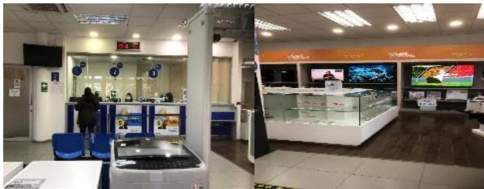
Piso 1: divisiones interiores en tabiquería de madera pintada, cielo falso en toda la superficie del primer nivel, en palmetas con lámparas fluorescentes sobrepuestas, pavimentos cubiertos con cerámicos en hall de atención y zonas húmedas como baños y kitchenette, piso de madera en oficinas y pasillos, ventanas en perfil de aluminio anodizado de corredera, puertas de acceso de cristal de dos hojas de abatir.
